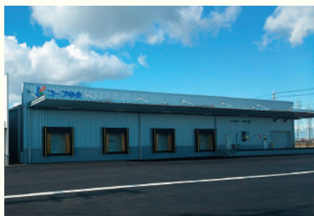
1月31日現在の新センター 外観(予定通り建設中)
